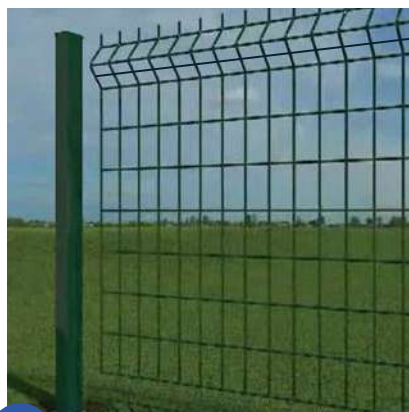
2 Colocar la malla al lado del poste
